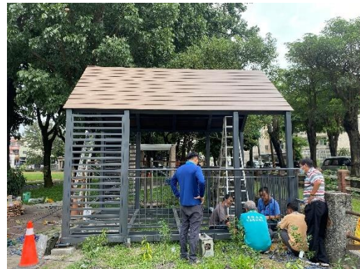
說明：穀倉屋地板、屋頂施作
