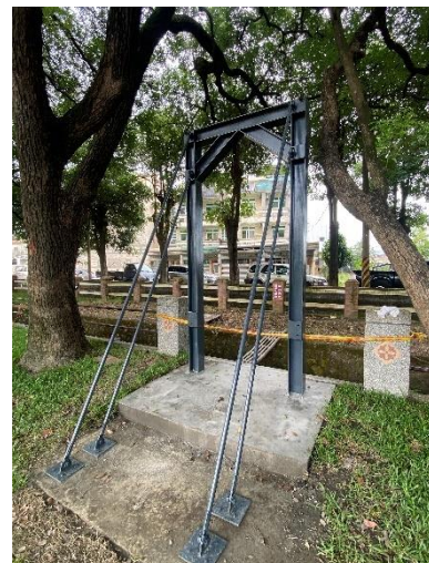
說明：重力斜撐橋施作
