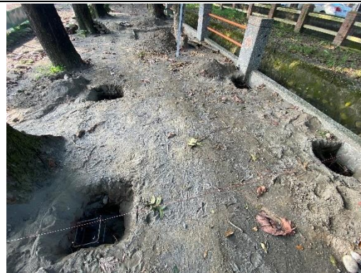
說明：基礎施作
