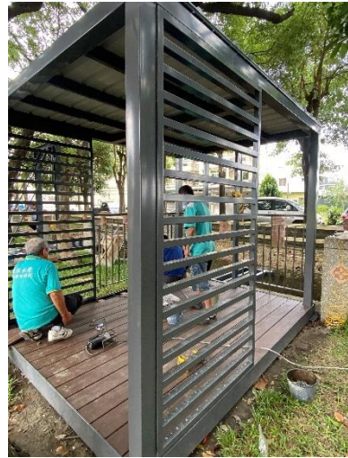
說明：成家亭地板、屋頂施作
