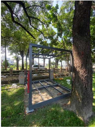
說明：成家亭鋼架施作
