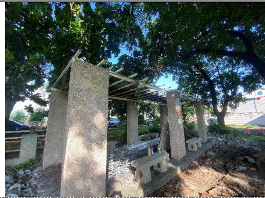
說明：花架區部分拆除
