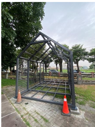
說明：穀倉屋鋼架施作
