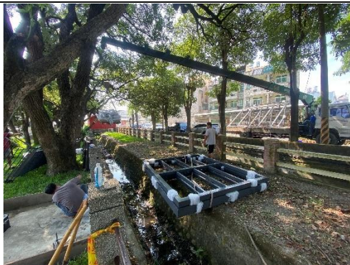
說明：材料進場施作
