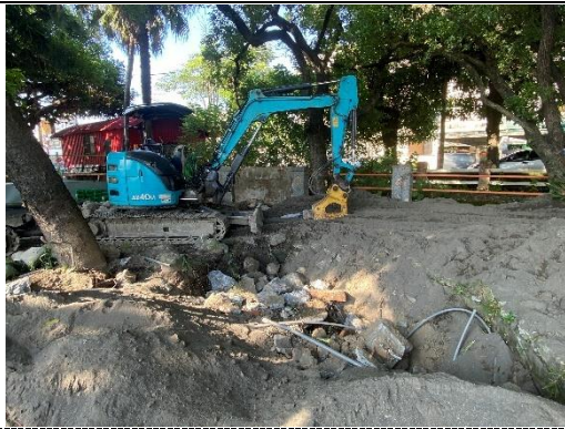
說明：步道拆除與土壤順平
