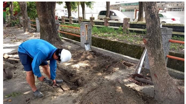
說明：基礎施作
