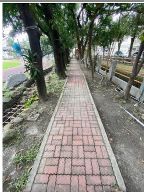
說明：施工前步道隆起不平
