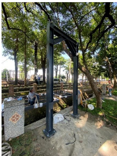
說明：重力斜撐橋施作
